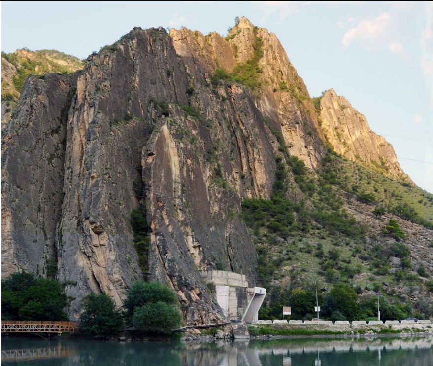
Фото № 198. Тоннель в скале и пешеходный мост через Гергебильское водохранилище.
