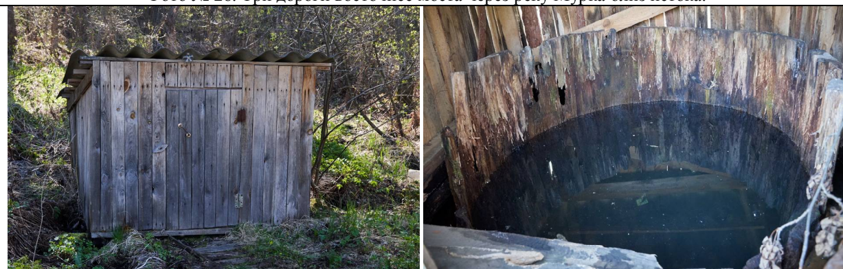
Фото № 29. Колодец на правом берегу реки Мурка восточнее моста.
