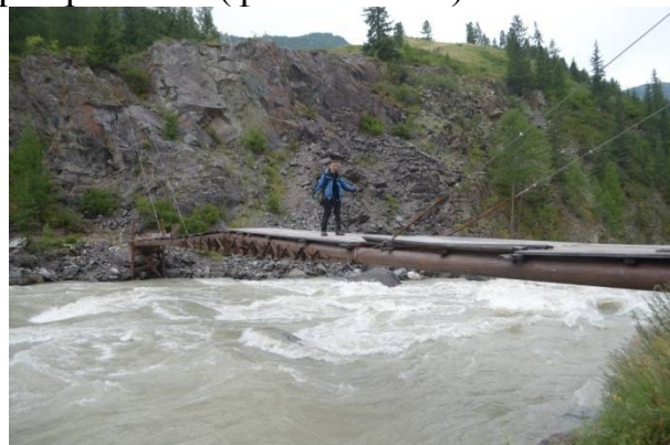
Фото 3.15.14. Мост через Чую
