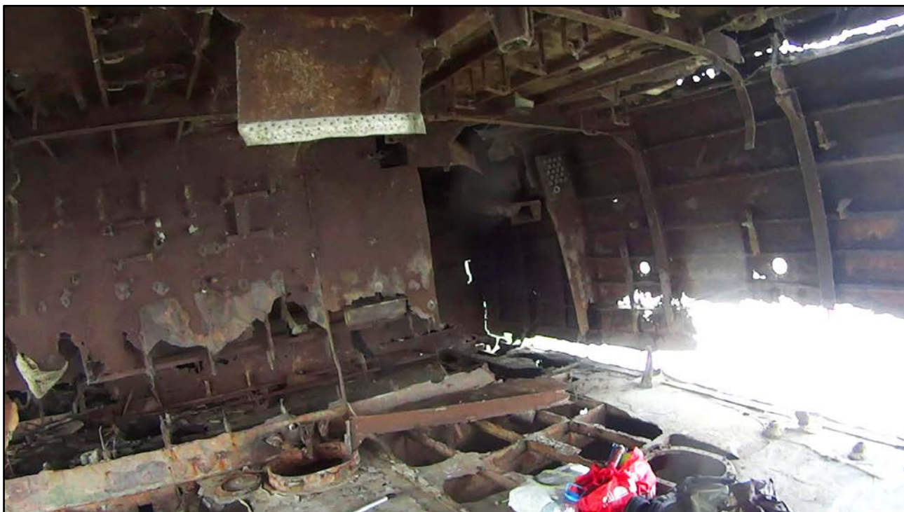
Фото 35 – Состояние судна изнутри
