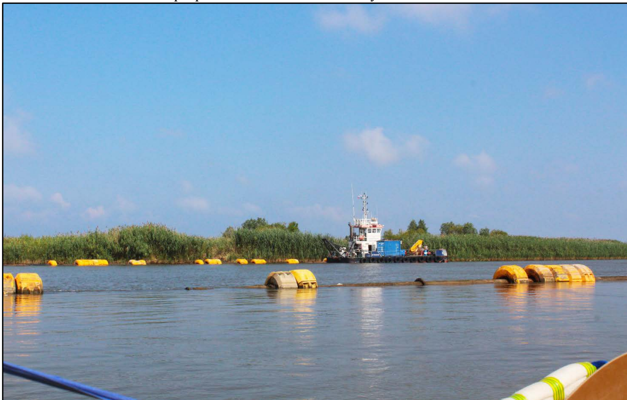
Фото 19 – Суда, проводящие углубление канала
