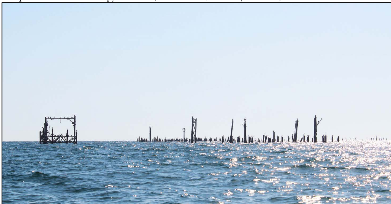
Фото 67 – Останки металлических конструкций в воде
