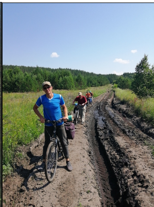
Фото 4. Разбитая дорога вдоль реки Мурки.
