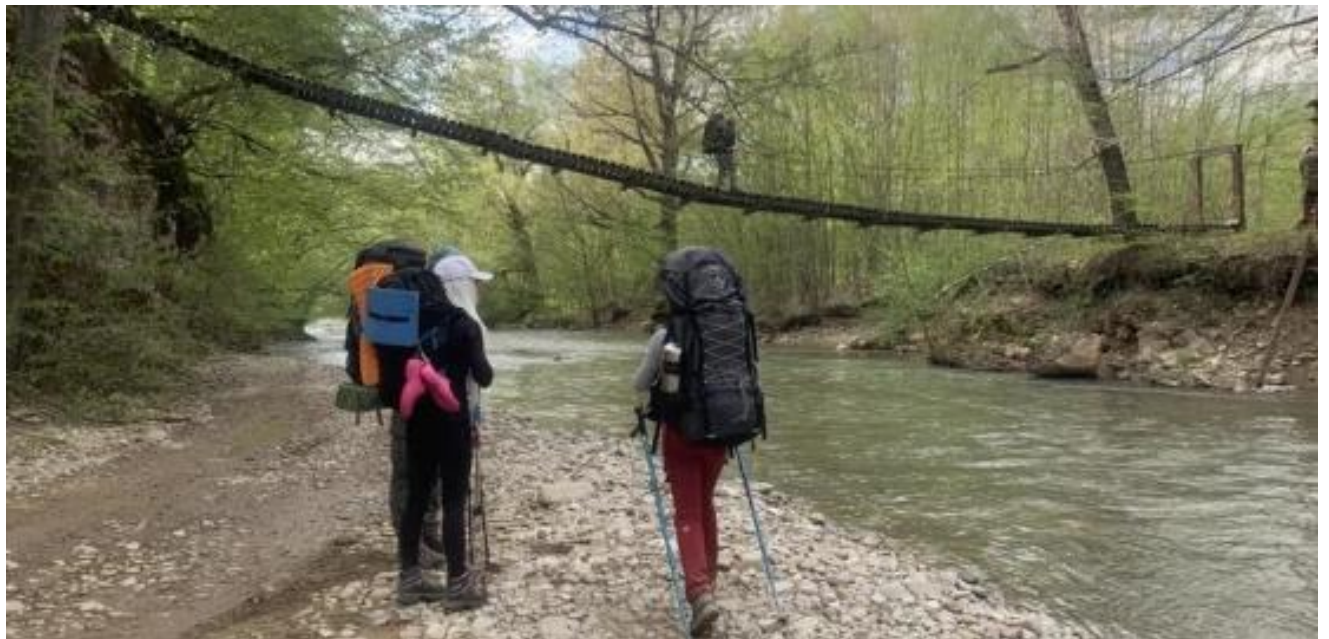
Рис 3 Мост через реку Сахрай
