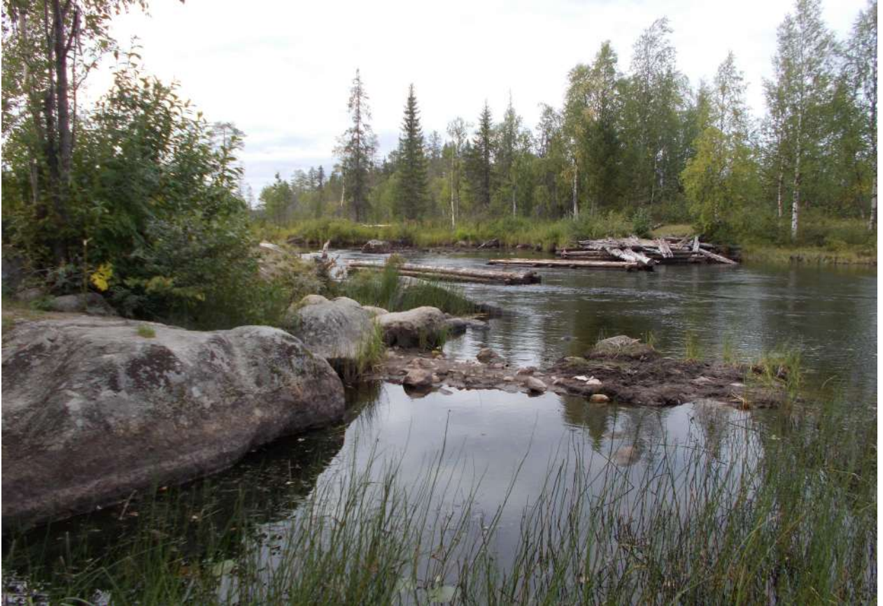
Фото 11. Порог «Сакал-порог» (III к.сл.). Вид на разрушенный мост снизу по течению.
