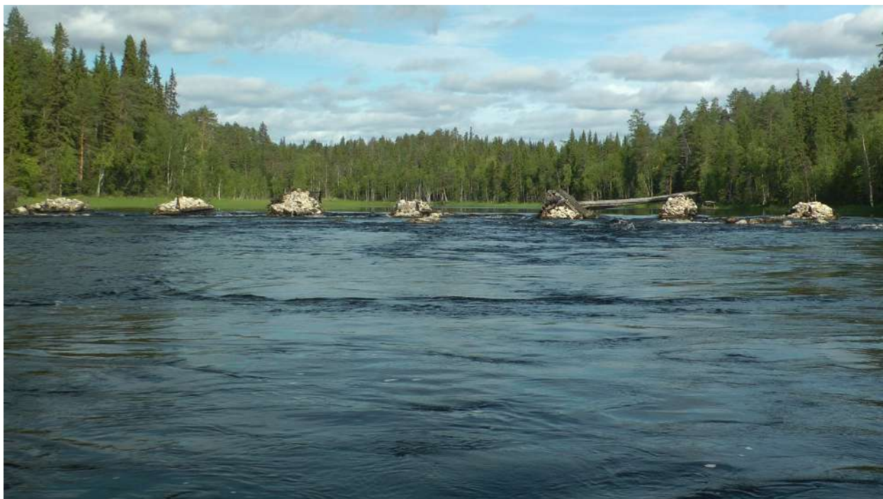
Фото 43. Старый разрушенный лесовозный мост. Опасность – скобы и строй.мусор.
