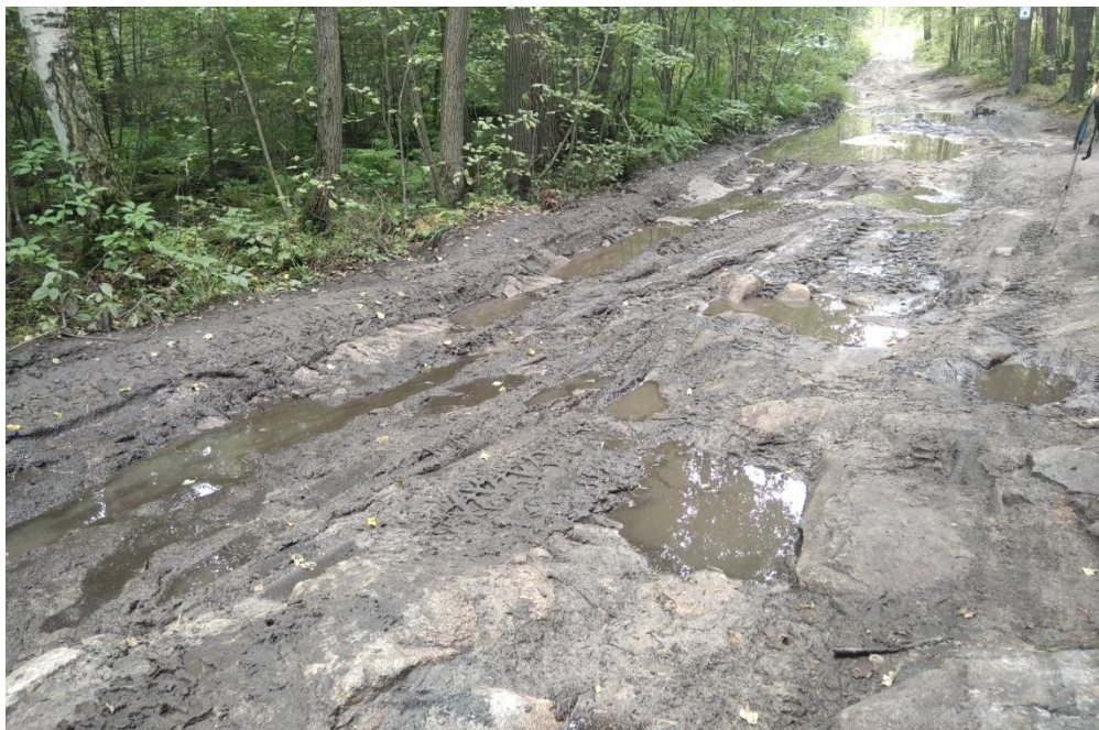
Фото 85. Размытая дорога после триатлона.
