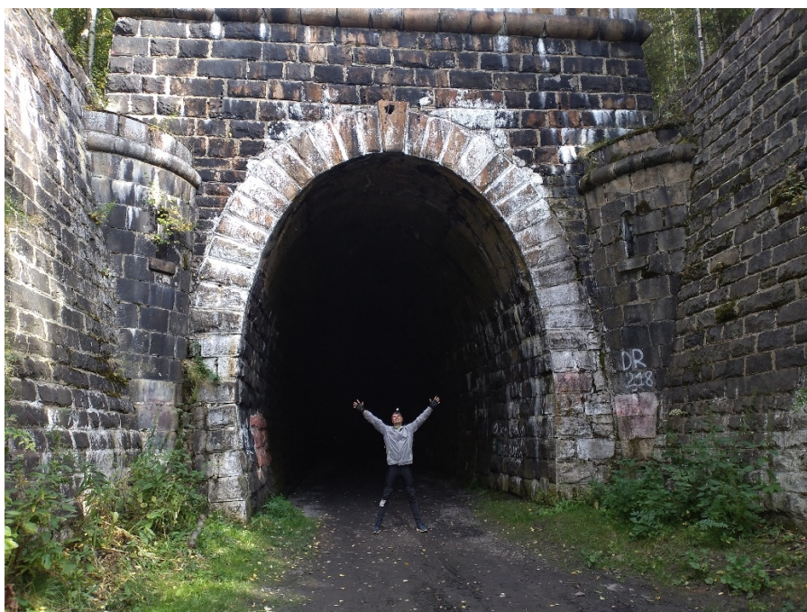
Фото 7. Западный портал Дидинского тоннеля.
