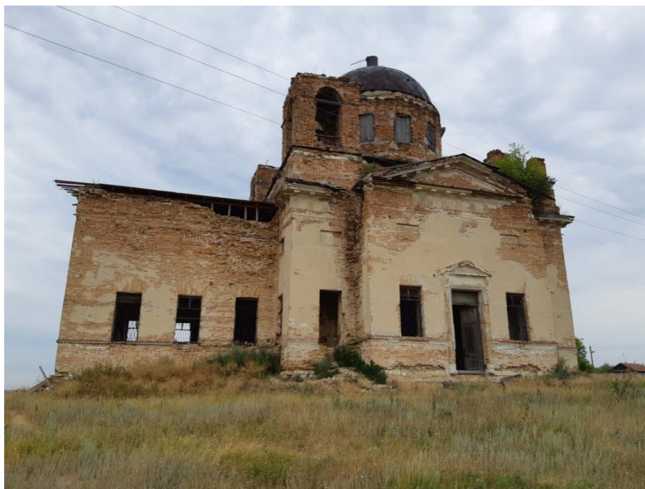
Разрушенный храм в Никитино
