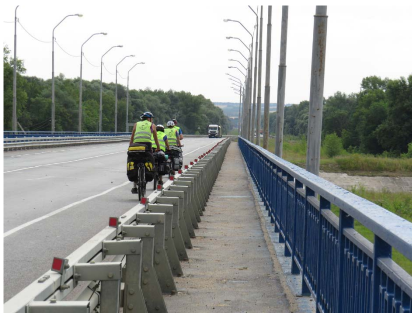
Мост через Суру
