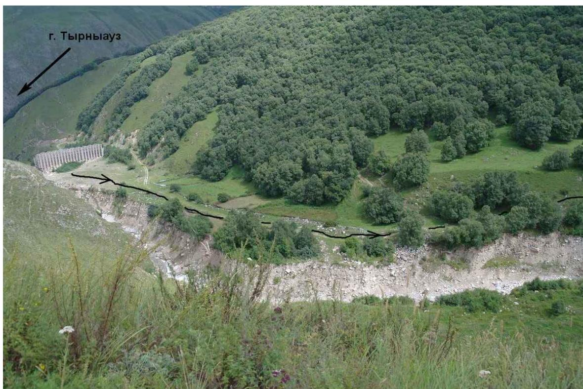
Фото № 001. Низовья долины Герхожан-су. Разрушенная селевая плотина. Съемка – с левого берега
