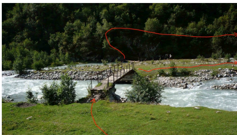
Фото № 142. Мост через реку Харес к югу от посёлка Куссу.
