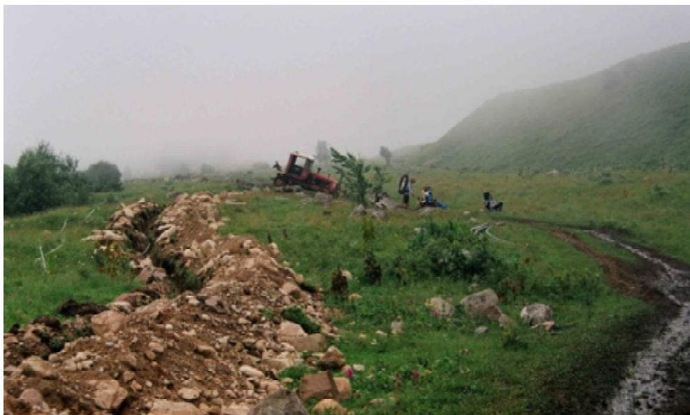
Фото № 4. Канавка для прокладки труб в долине реки Беяги-дон.
